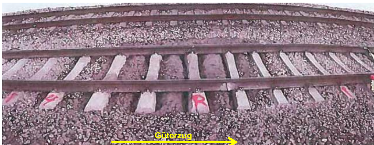
Abbildung 33 Spritzstoß an der Entgleisungsstelle am 15. Februar 2013, ohne Uhrzeit (Quelle IM)
