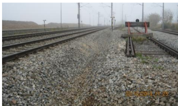
Abbildung 48 Entwässerung an der Entgleisungsstelle am 22. Oktober 2013 (Quelle SUB)
