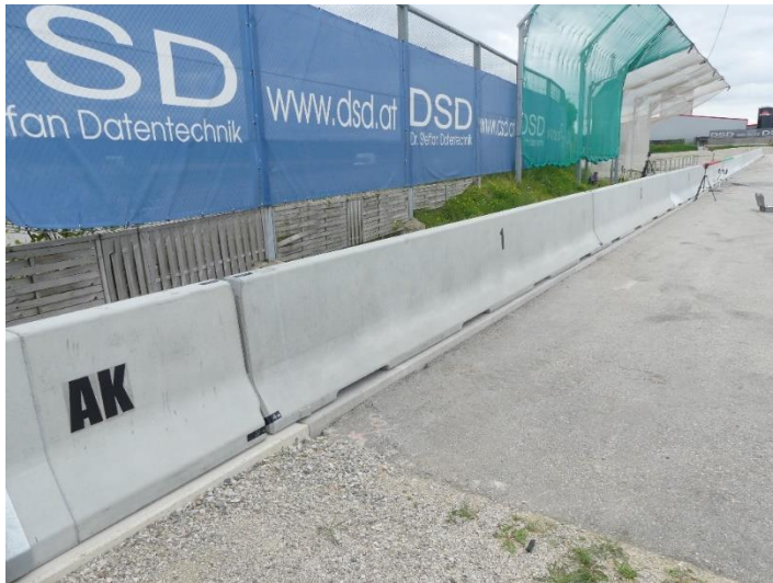
Abbildung 9: Prüfaufbau REB22004 - REBLOC 100.1_8
