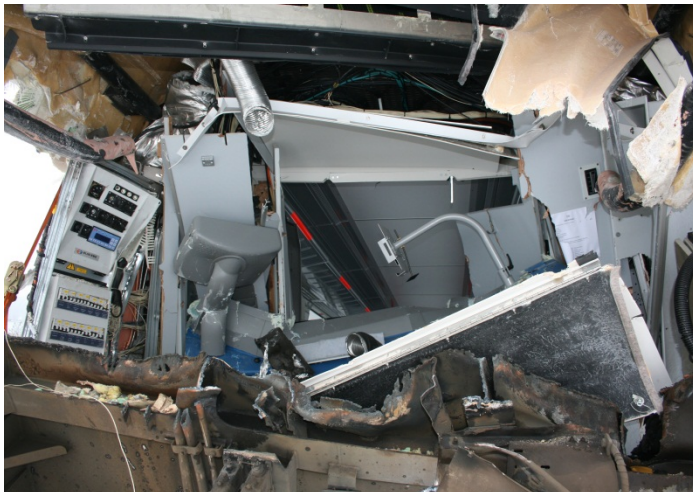
Abbildung 11: Bilddokumentation 23. Jänner 2013 – Teil 2 (Quelle SUB)
