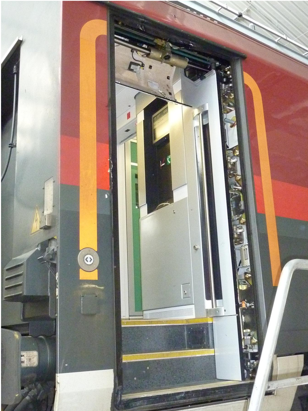
Abbildung 15 Gesamtansicht der Türöffnung (Quelle RU)
