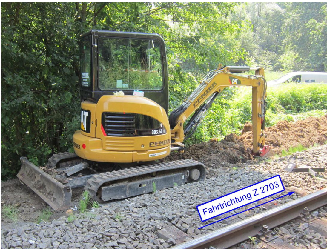
Abbildung 10 Gleisbaustelle – Bagger außerhalb Gefahrenbereich (Quelle SUB)
