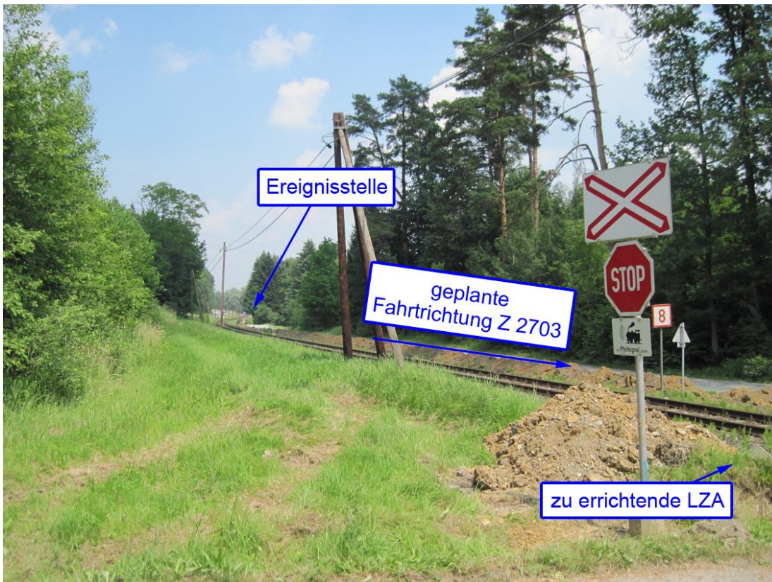
Abbildung 9 Blick von EK km 24,020 zur Ereignisstelle (Quelle IM)
