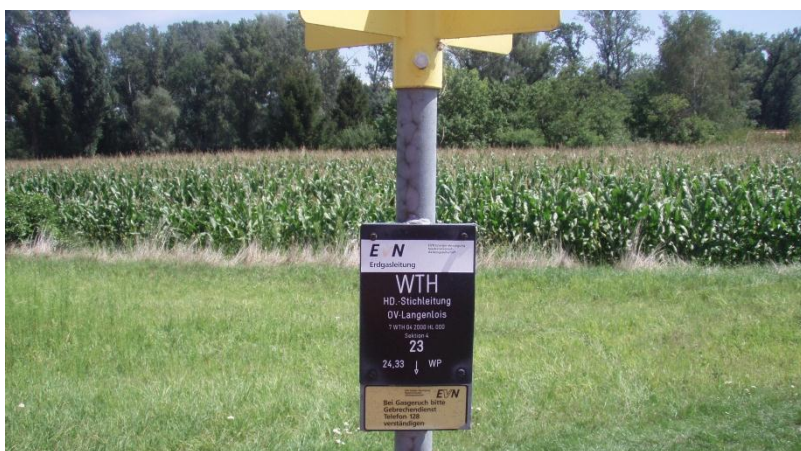
Abbildung 17 Detailansicht der Kennzeichnung unterirdischer Gasleitungen
