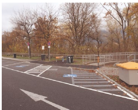
Angehobene Gehsteige sorgen für flachere Rampen
