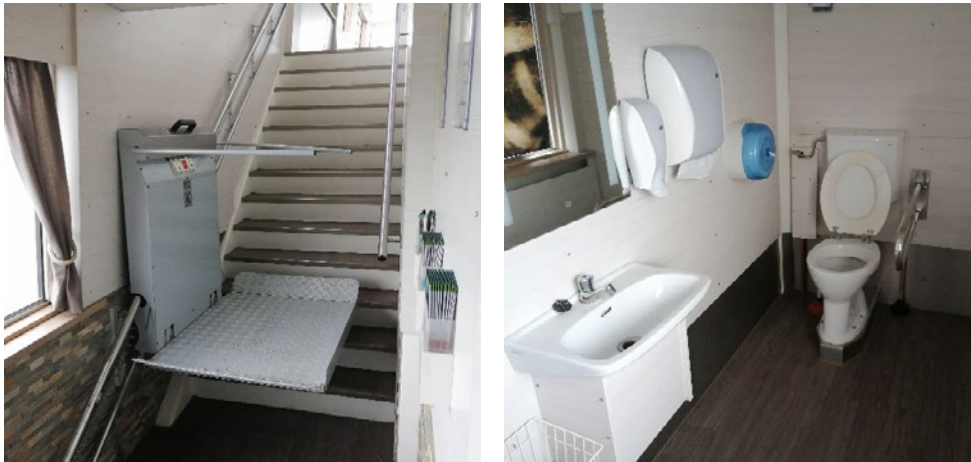
Hebelifte helfen Stufen zu überwinden
