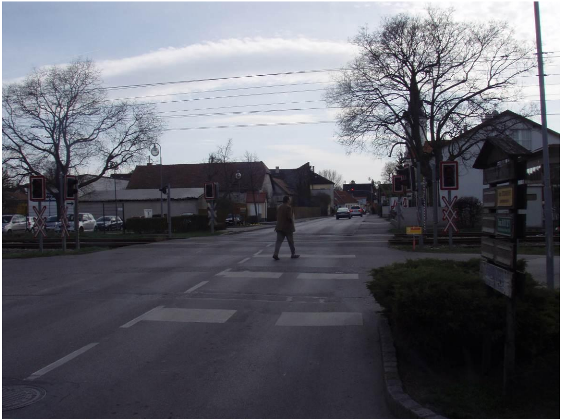
Abbildung 4 Ansicht der EK in Fahrtrichtung des PKW
