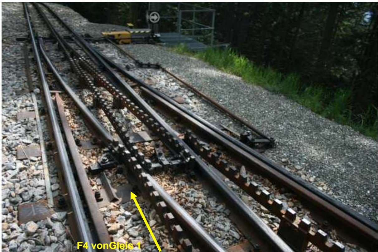
Abbildung 16 Weiche 1 – Gestänge bei richtiger Stellung der Zungen
