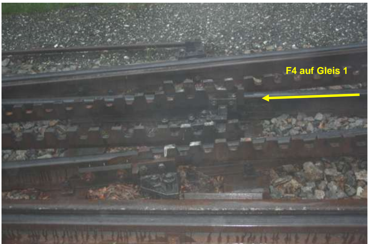
Abbildung 14 Weiche 1 – unrichtige Stellung der Zahnstangenenden bei Durchfahrt auf Gleis 1
