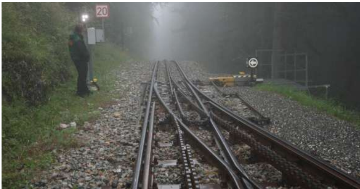
Abbildung 7 Aw Wasserstelle am Hengst – Weiche 1 in Fahrtrichtung F4
