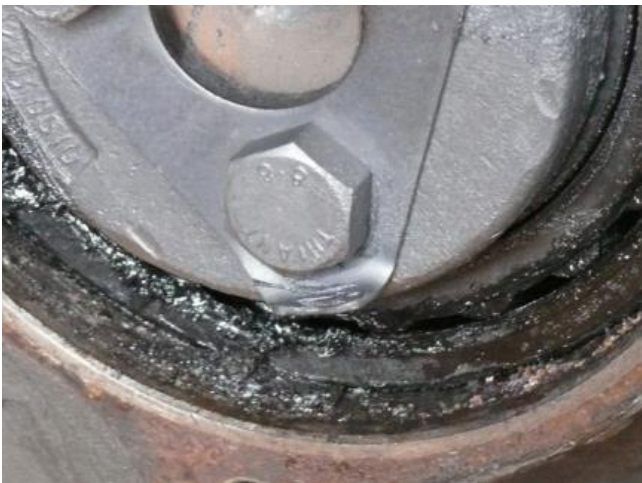
Abbildung 19 Mangelhafte Schraubensicherung der Druckkappe (Quelle Expertise [1])
