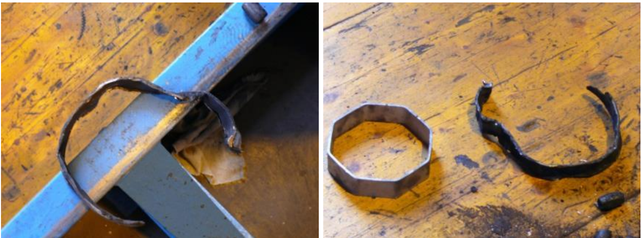
Abbildung 25 Beschädigter Distanzring und Vergleich mit neuem Distanzring (Quelle Expertise [1])
