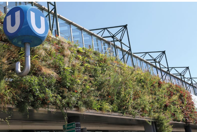
Abbildung 4: Begrünung einer U-Bahn- Station Foto: Umweltbundesamt/ B. Gröger
