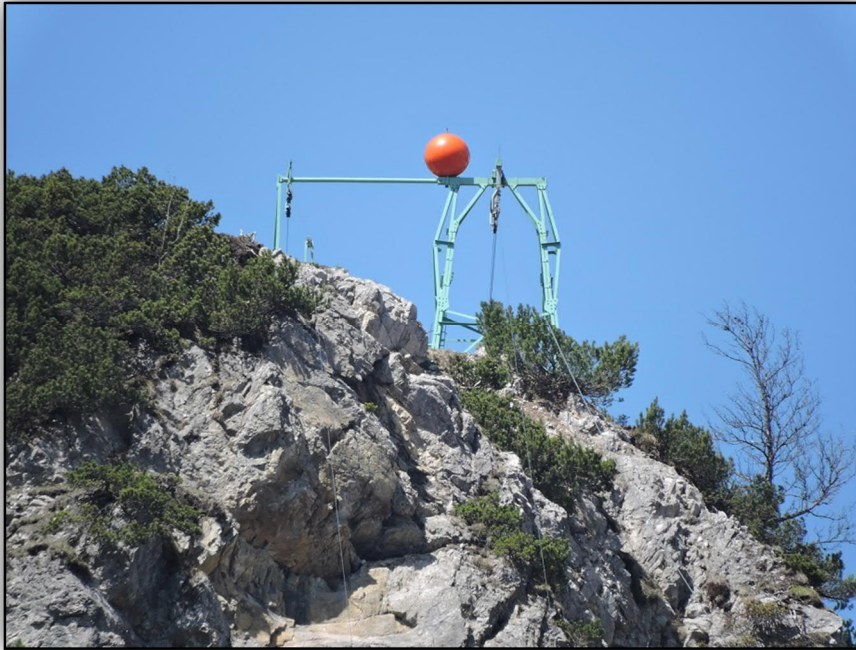
Abbildung 7: Stütze 1 der Seilwegsanlage Gramaialm (Quelle SUB)
