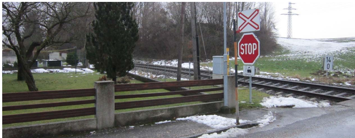
Abbildung 14 Ansicht gegen die Fahrtrichtung Z 7023 von der Haltelinie
