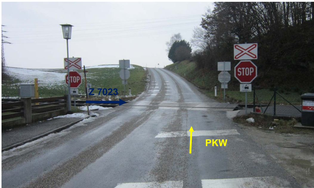
Abbildung 7 Ansicht der EK km 13,985
