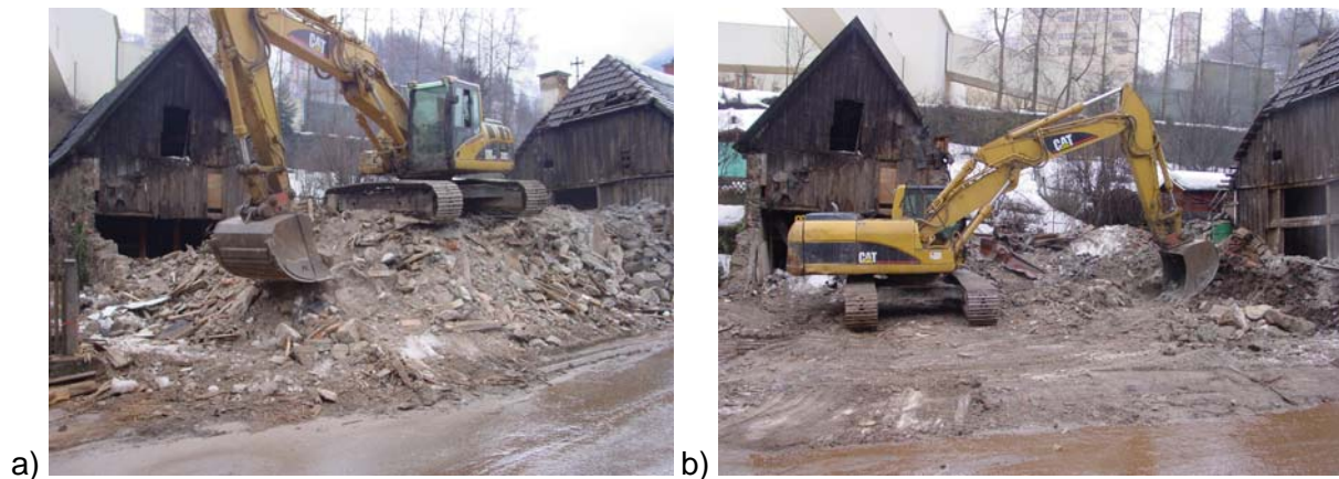
Abbildung 3-25: Schrittweises Abgraben des Schuttberges a) am Beginn; b) am Ende
