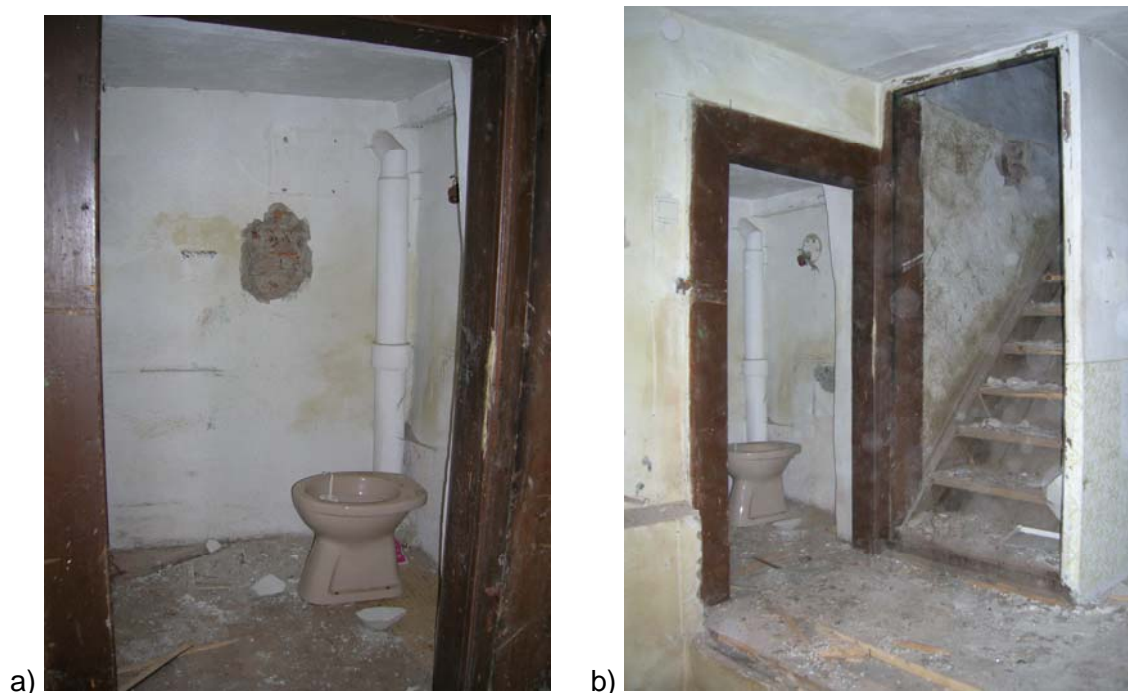
Abbildung 3-11: a) Raum 107; b) Raum 101 mit Blick in Raum 107 u. Aufgang zur Mansarde
