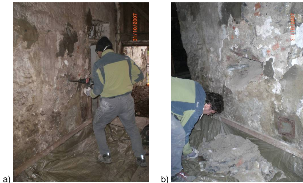
Abbildung 3-15: Ausstemmen und Einfassen des Probenmaterials von der Außenmauer im Erdgeschoß
