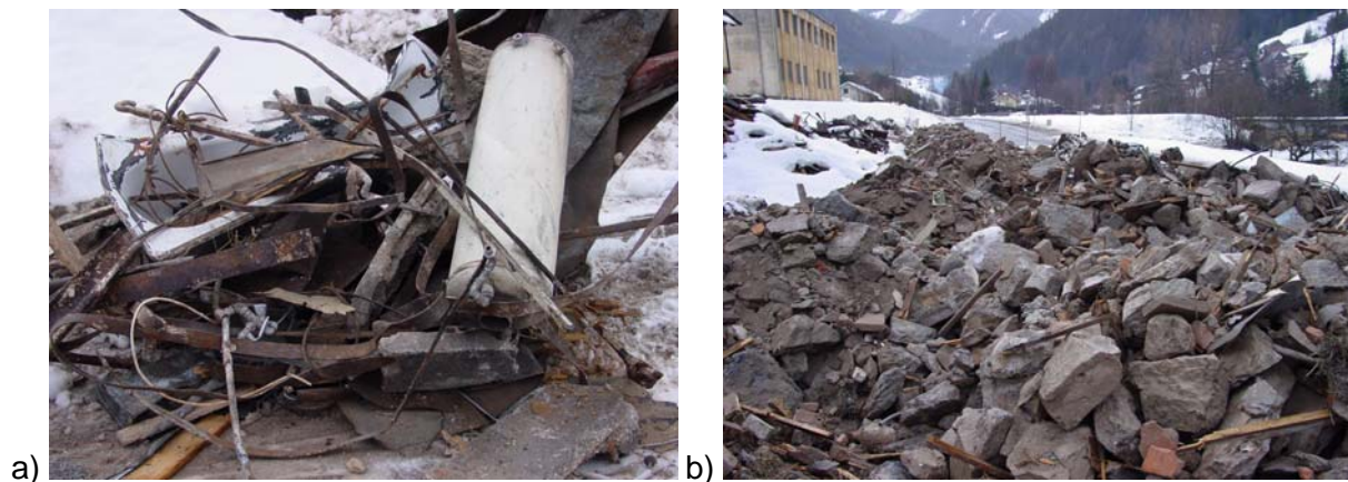
Abbildung 3-24: Separierte Metallfraktion (a) und abgekipptes Abbruchmaterial (b) am Zwischenlagerplatz
