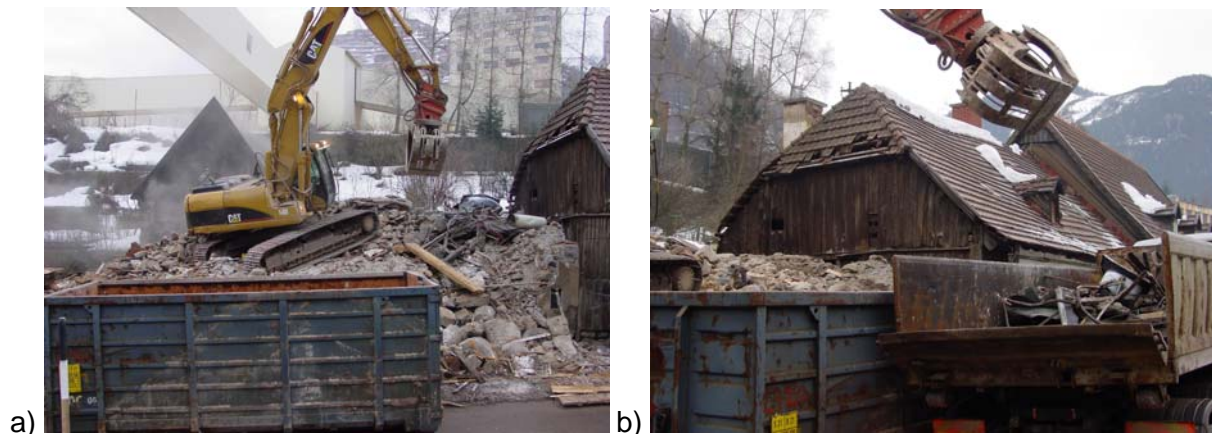
Abbildung 3-21: Aussortieren von Holz- und Metallteilen aus dem Abbruchmaterial
