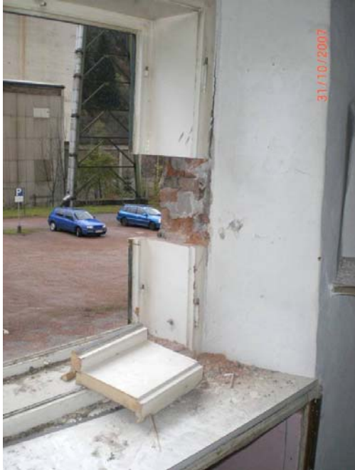
Abbildung 3-20: Ausgeschnittener Teil des Fensterstocks als Probe (Raum 105)
