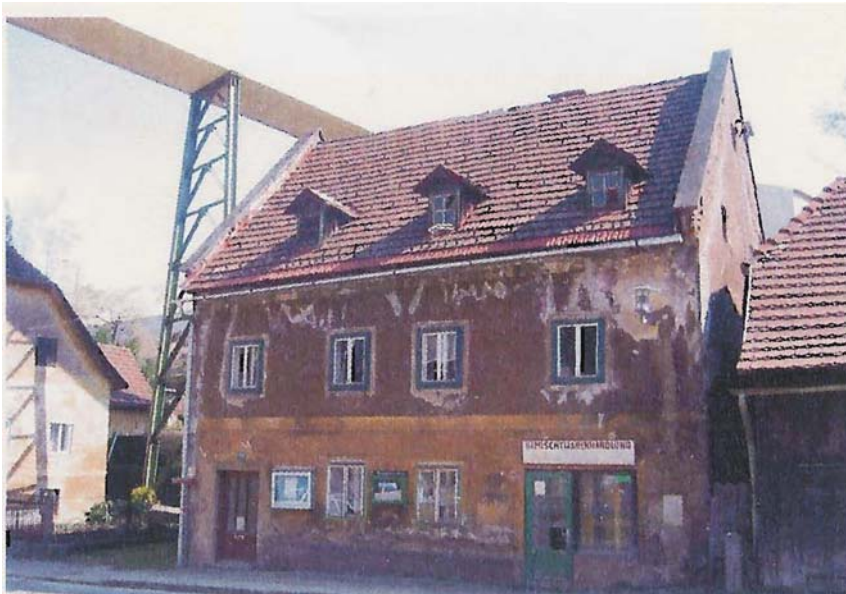
Abbildung 3-2: Abbruchobjekt Krumpentalerstraße 74, 8790 Eisenerz
