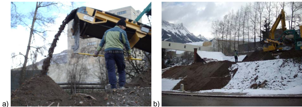
Abbildung 3-27: a) Separation von Kabeln beim Auswurf der Aufbereitungsanlage; b) Die aus Bauschutt geschüttete Böschung
