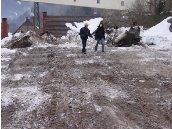
Abbildung 3-23: Planierter Zwischenlagerplatz vor dem abkippen des Abbruchmaterials
