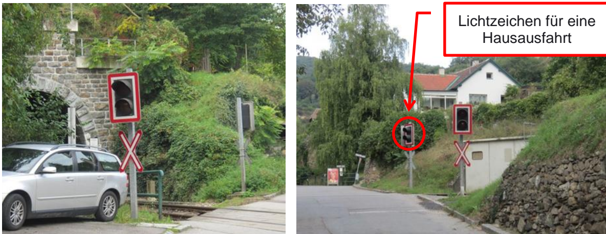
Abbildung 8 Lichtzeichen der EK km 2,555 mit Gefahrenzeichen „Andreaskreuz“ (Quelle SUB)
