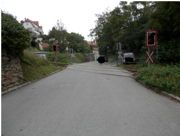
Abbildung 11 Fehlende Haltelinie und Sicht in Richtung der Fahrt aus Fahrtrichtung 2 (Quelle SUB)
