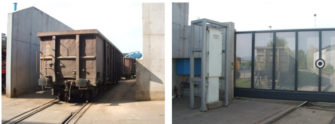
Abbildung 36: Beengte Platzverhältnisse für die Bahnverladung und bahnseitiges Ausgangsportal für Radioaktivitätsmessung, dahinter Wagonbereitstellung
