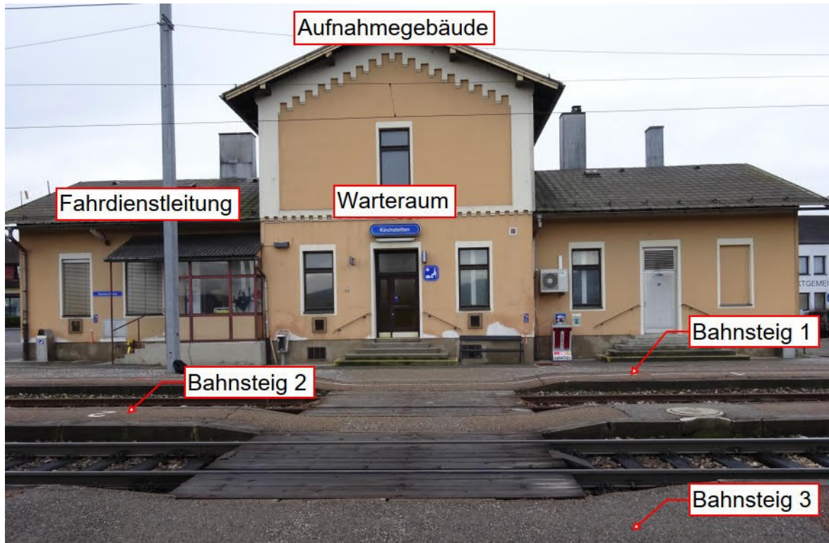
Abbildung 3 Aufnahmegebäude des Bf Kirchstetten (schienenseitig)
