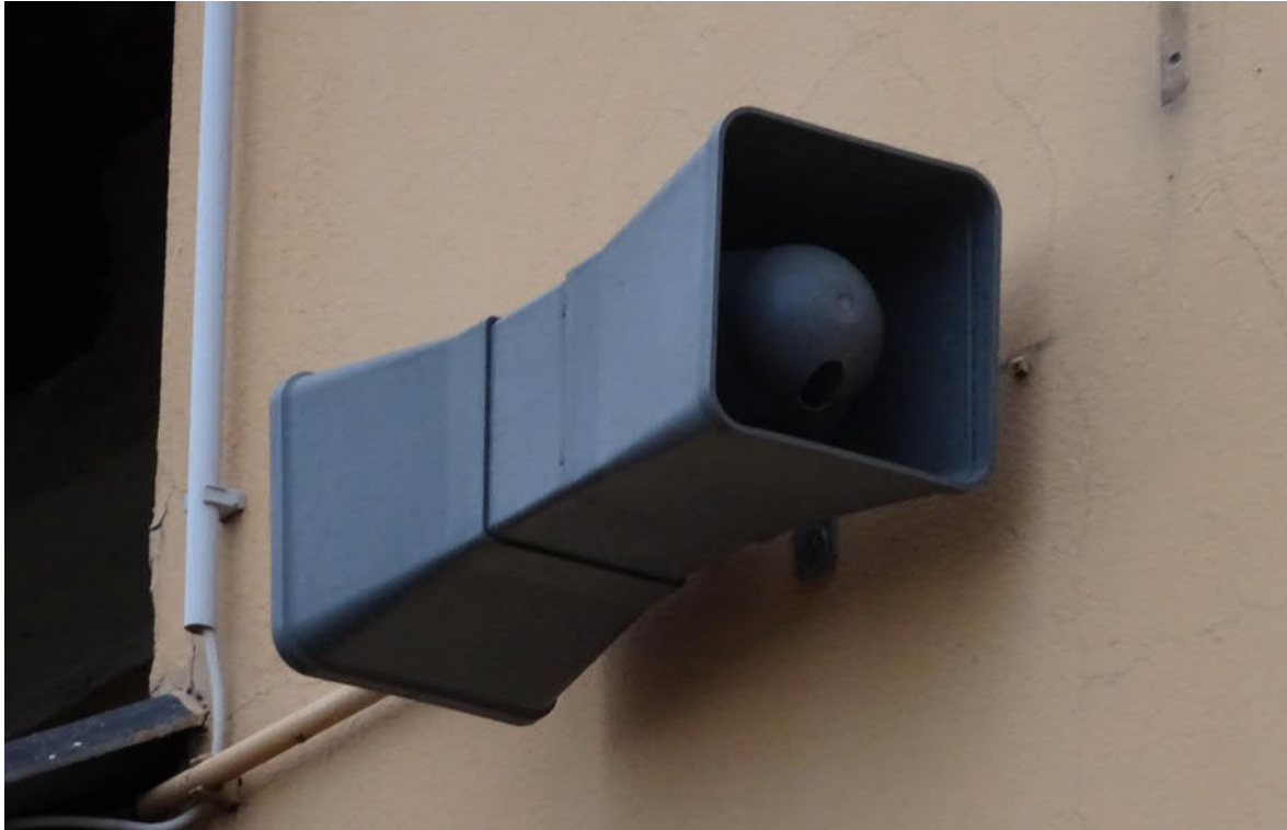
Abbildung 13 Im Außenbereich montierter Lautsprecher
