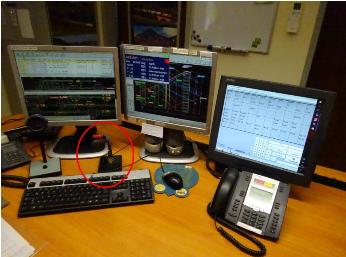
Abbildung 16 Mikrophon der Lautsprecheranlage
