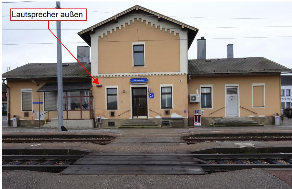
Abbildung 12 Lautsprecher montiert auf der Außenfassade des Aufnahmegebäudes
