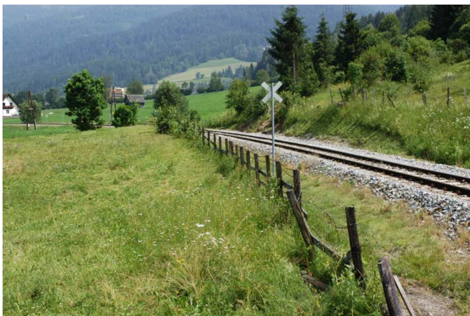
Abbildung 5 Sicht bei der EK rechts der Bahnstrecke (Quelle SUB)
