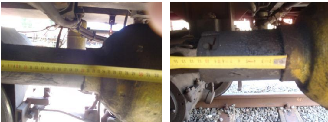
Abbildung 17 Zustand der Bremszylinder - Quelle TUE
