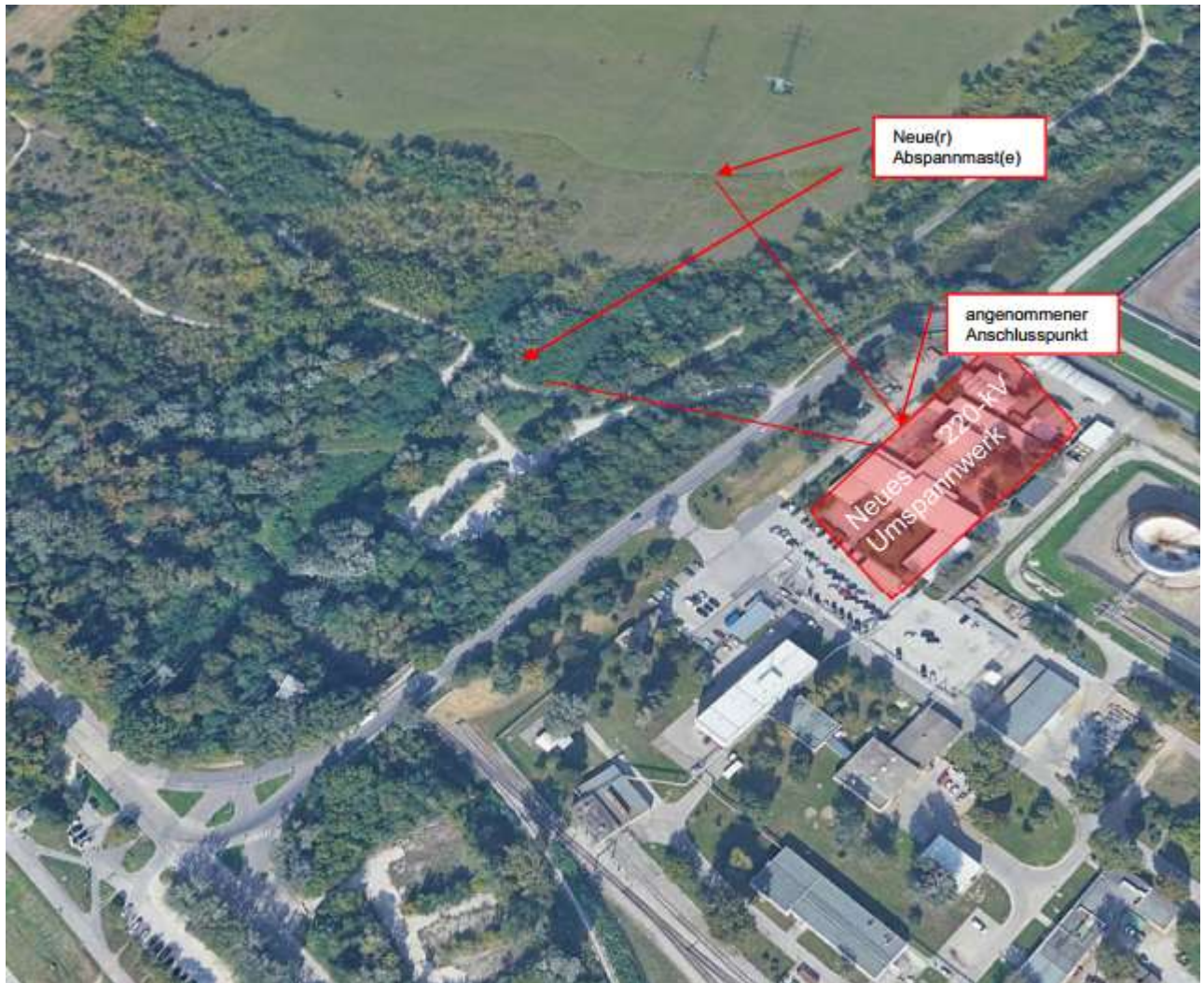
Abbildung 2: Netzanschlusspunkt an der bestehenden 220-kV Leitung Bisamberg-Südost im Bereich Tanklager Lobau (OMV Downstream GmbH, 2022)
