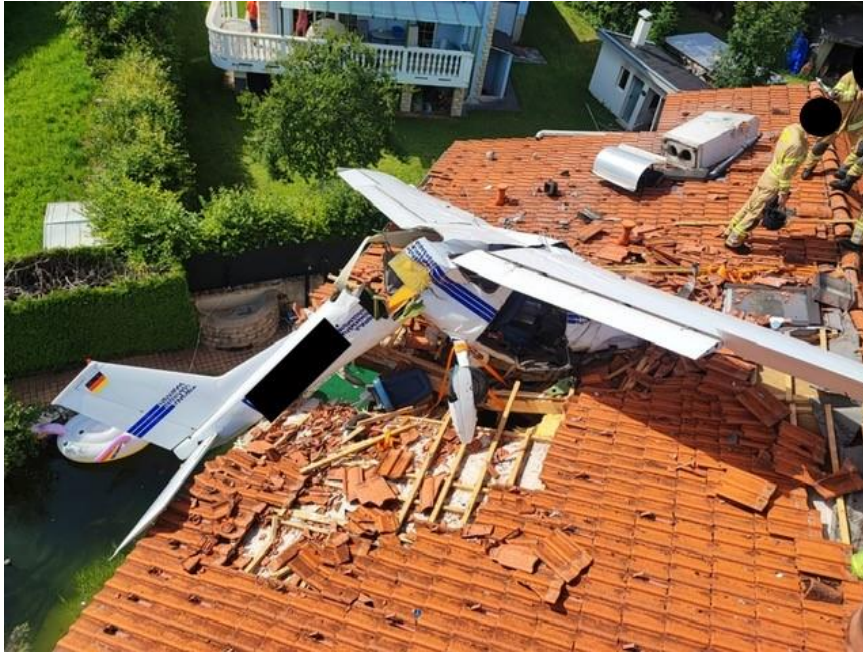
Abbildung 13 Unfallstelle - Hausdach nach Bergung der Insassen
