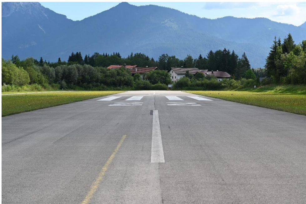
Abbildung 11 Piste 04 im Bereich der Schwelle Piste 22, Hindernissituation
