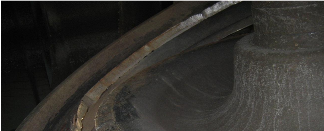
Abbildung 21 Ansicht der Bruchfläche am Radkranz - Quelle [1]
