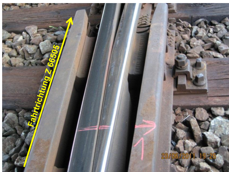
Abbildung 6 Entgleisungsspuren am Herzstück der Weiche 12 - Quelle [1]
