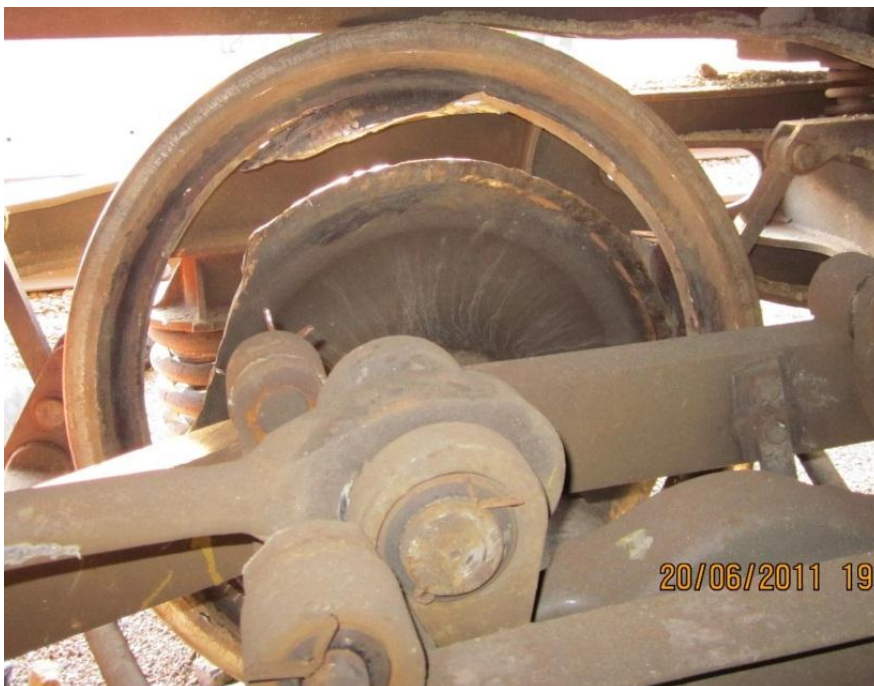
Abbildung 20 Innenansicht der gebrochenen Radscheibe vor Ort - Quelle TUE
