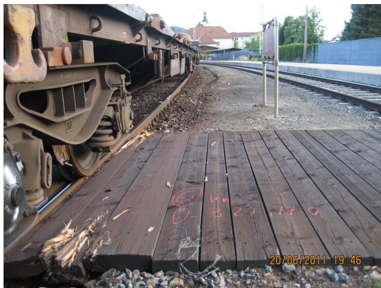
Abbildung 9 Entgleisungsspuren am n-ö EÜ - Quelle [1]
