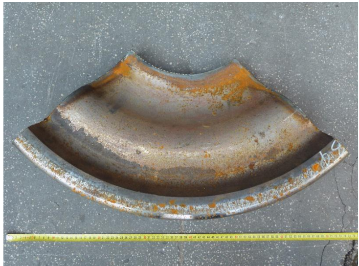
Abbildung 31 Innenseite eines rissbehafteten Radsegments - Quelle [4]
