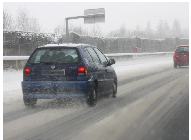
Abb. 78: Verteilung von Schneematsch durch den Verkehrseinfluss
