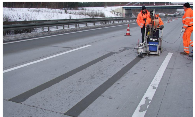
Abb. 12: Ausbringung einer bekannten Streumittelmenge und Messung der verbleibenden Restsalzmenge mit dem Saugspülgerät der BAST [HAUSMANN, 2010]
