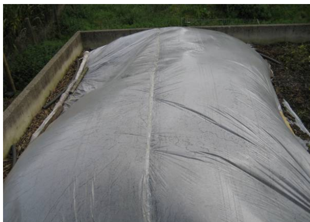
Abbildung 8-3: Flächenbiofilter mit offener Ausströmung, im Bild zum Zweck der Abluftprobenahme mit dünner Folie kurzzeitig gekapselt
