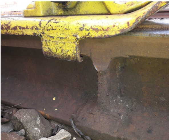
Abbildung 9: Ein sperrbarer Hemmschuh vor einer Thermit-Schweißstelle
