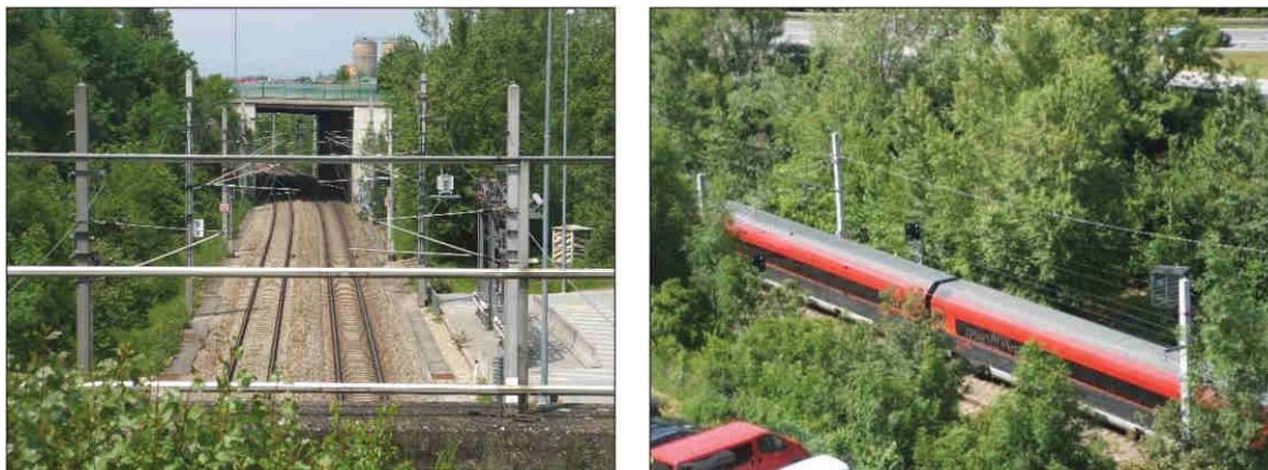
Abbildung 3.2-11: Die Bahntrasse zum Flughafenbahnhof am Westportal mit Tunnelrettungsplatz
