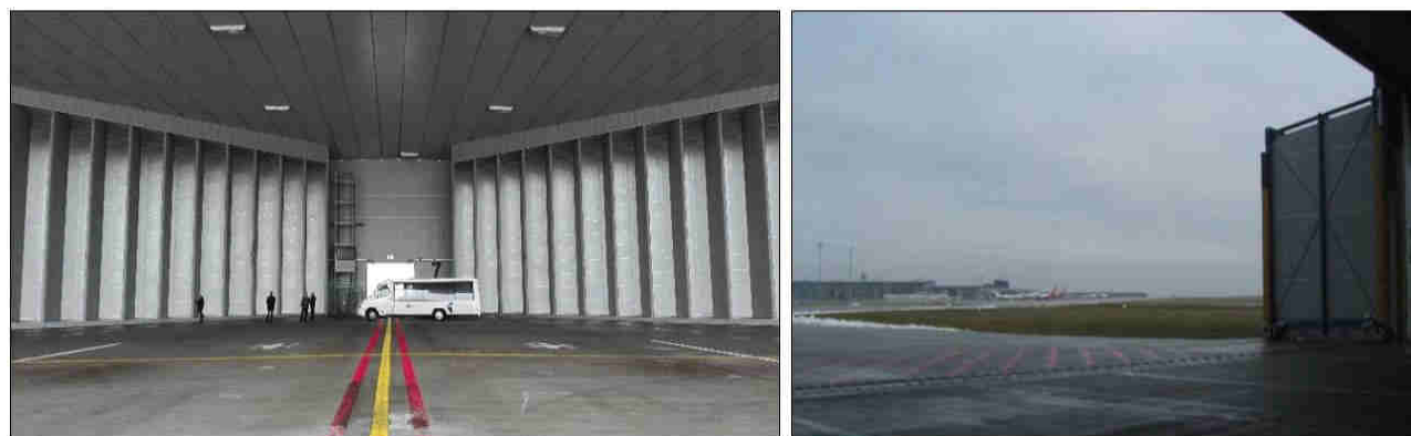
Abbildung 2.2-5: Lärmschutzhalle für Triebwerksprobelläufe am westlichen Flughafengelände
