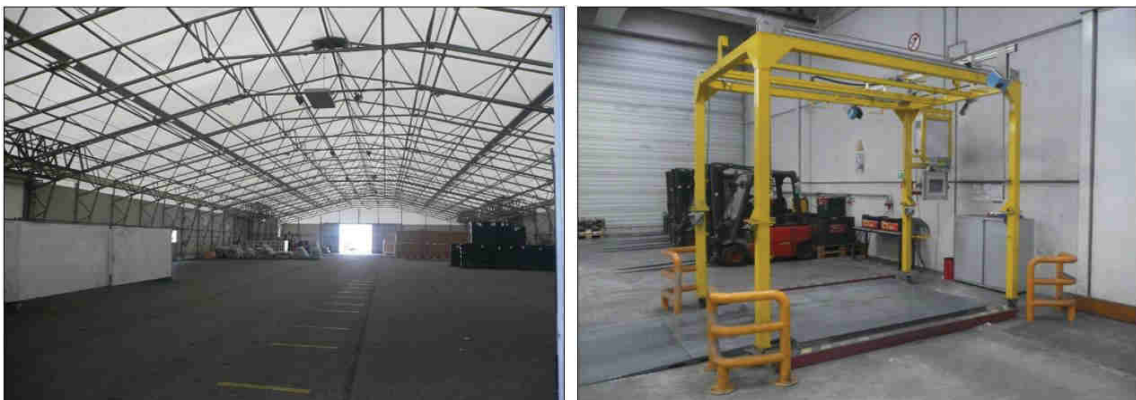
Abbildung 3.3-6: Freilufthalle für zusätzlichen Bedarf und Rundum-Messgerät für das Cargo Handling
