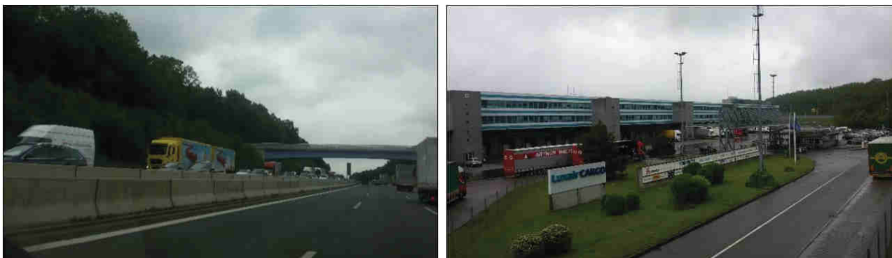
Abbildung 2.2-22: Die Zulaufautobahn A 1 und das Zufahrtskontroll-Gate zum Luxair-Cargo -Center
