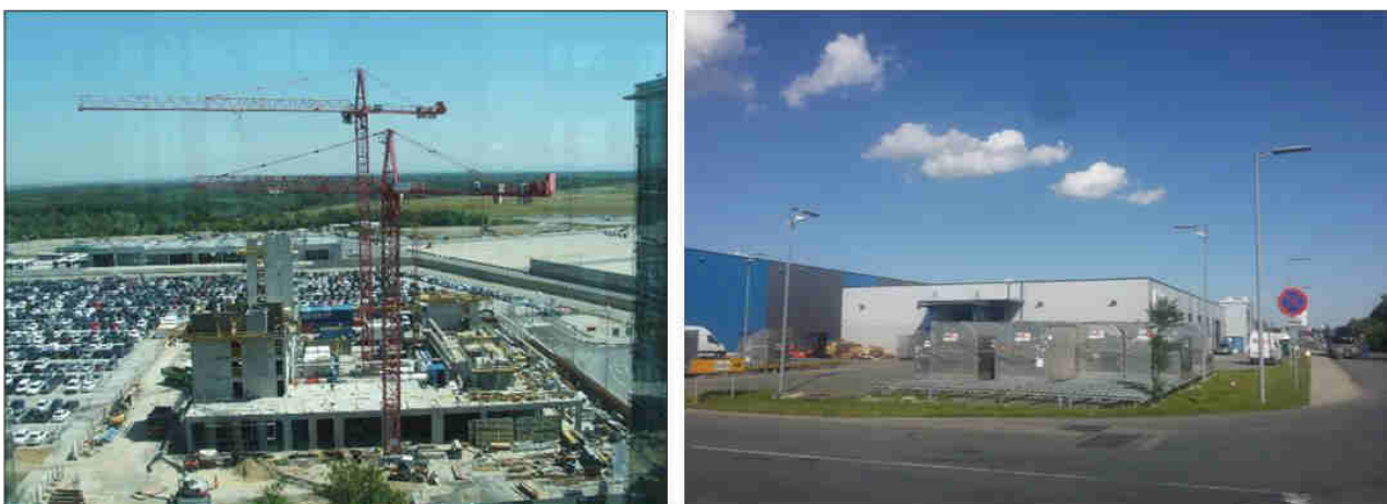
Abbildung 3.2-14: Baustelle für ein Hotel am Parkplatz Nord benachbart zum Vorfeld K für Frachtflugzeuge (links) und Cargo City Nord (rechts)
