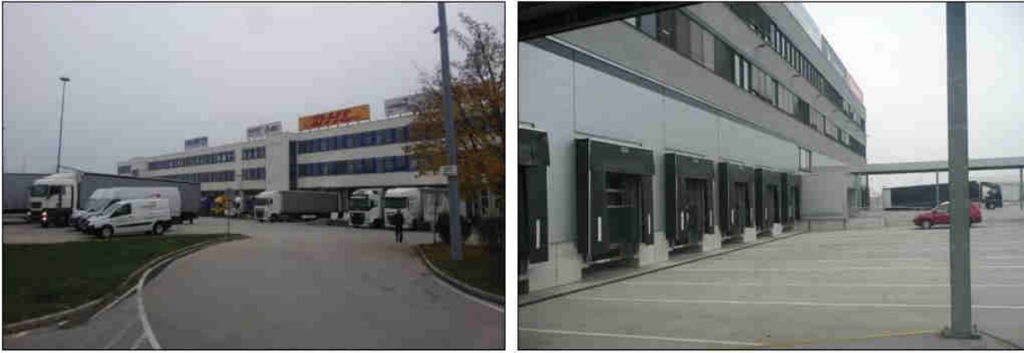
Abbildung 3.3-3: Frachtzentrum mit dem Bürotrakt der eingemieteten Speditionen und den Andockstationen zur Frachthalle straßenseitig und als Besonderheit ebenso zum Fluggelände hin
