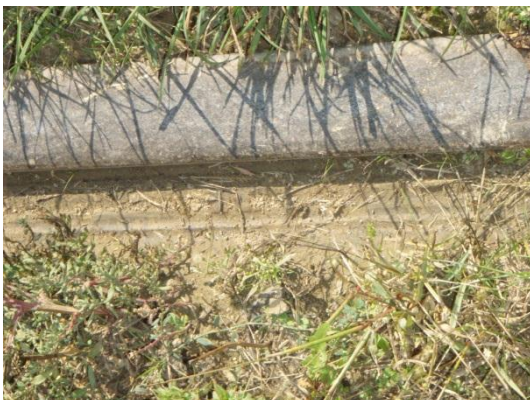
Abbildung 69 Stark verschmutzte Gleisanlagen im Bereich vor und nach der EK km 22,618 – Bilder 3 u. 4 - Quelle IM
