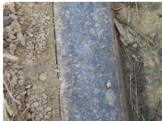
Abbildung 69 Stark verschmutzte Gleisanlagen im Bereich vor und nach der EK km 22,618 – Bilder 3 u. 4 - Quelle IM
