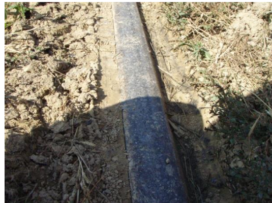
Abbildung 68 Stark verschmutzte Gleisanlagen im Bereich vor und nach der EK km 22,618 – Bilder 1 u. 2 - Quelle IM
