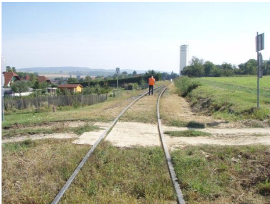
Abbildung 68 Stark verschmutzte Gleisanlagen im Bereich vor und nach der EK km 22,618 – Bilder 1 u. 2 - Quelle IM
