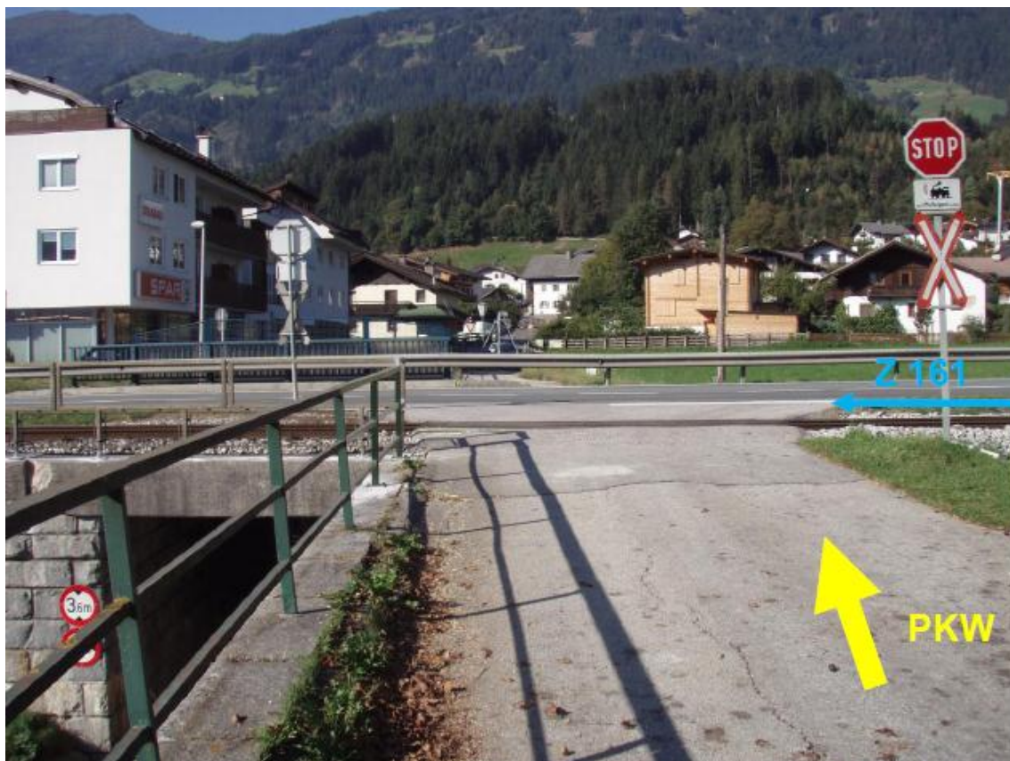
Abbildung 4 Blick auf EK aus Fahrtrichtung PKW – Quelle IM
