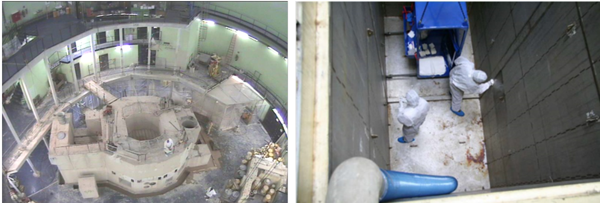
Abbildung 1: Rückbau des Forschungsreaktors ASTRA und des Brennelementelagerbeckens; Bilder: © NES GmbH
