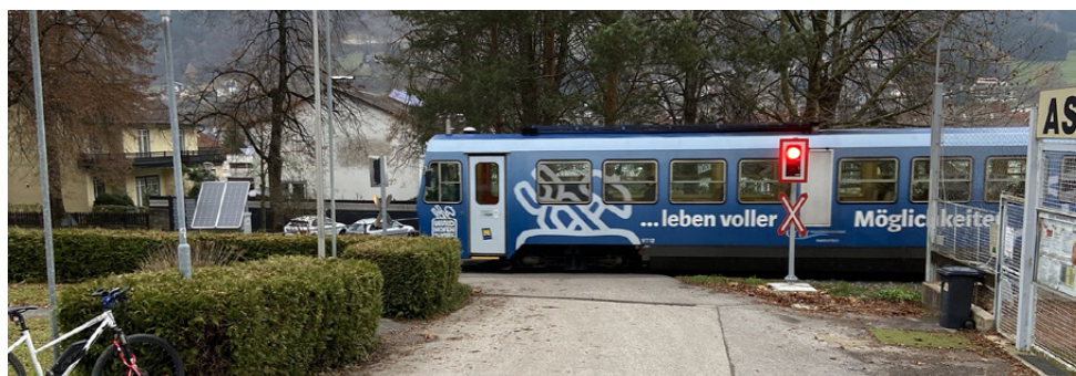
Abbildung 9: Vereinfachte Technische Sicherungsanlage (VTS) in Waidhofen/Ybbs © AIT/Aleksa
