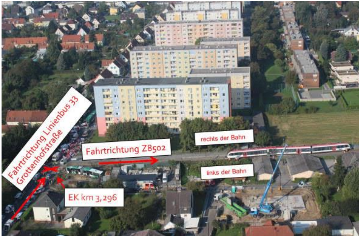
Abbildung 2 EK 3,296 Luftaufnahme der Unfallstelle
