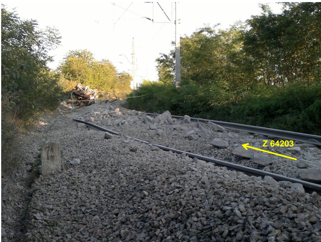
Abbildung 25 Entgleisungsfolgen ca. 100 m nach der Entgleisungsstelle - Quelle RU
