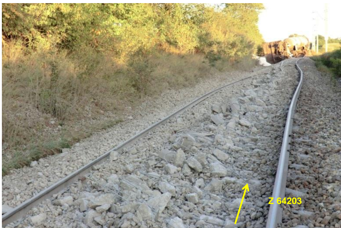
Abbildung 27 Entgleisungsfolgen ca. 250 m nach der Entgleisungsstelle und vorderer Zugteil von Z 64203 - Quelle RU
