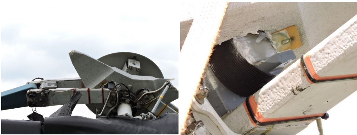
Abbildung 10 (linkes Bild): Beschädigung des Blattanschlusses von Hauptrotorblatt ROT (Übersicht) Abbildung 11 (rechtes Bild): Beschädigung des Blattanschlusses von Hauptrotorblatt ROT (Detail)
