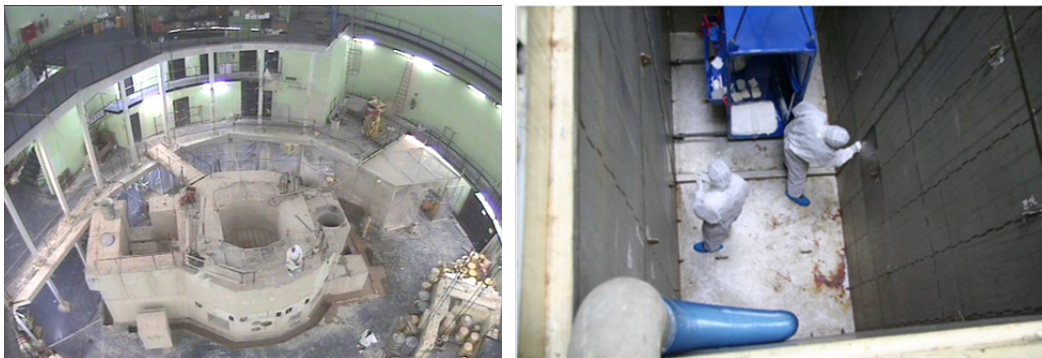
Abbildung 1: Rückbau des Forschungsreaktors ASTRA und des Brennelementlagerbeckens
