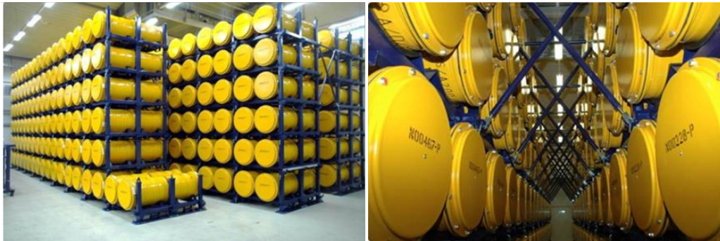
Abbildung 5: Zwischenlagerung der konditionierten 200 Liter-Fässer
