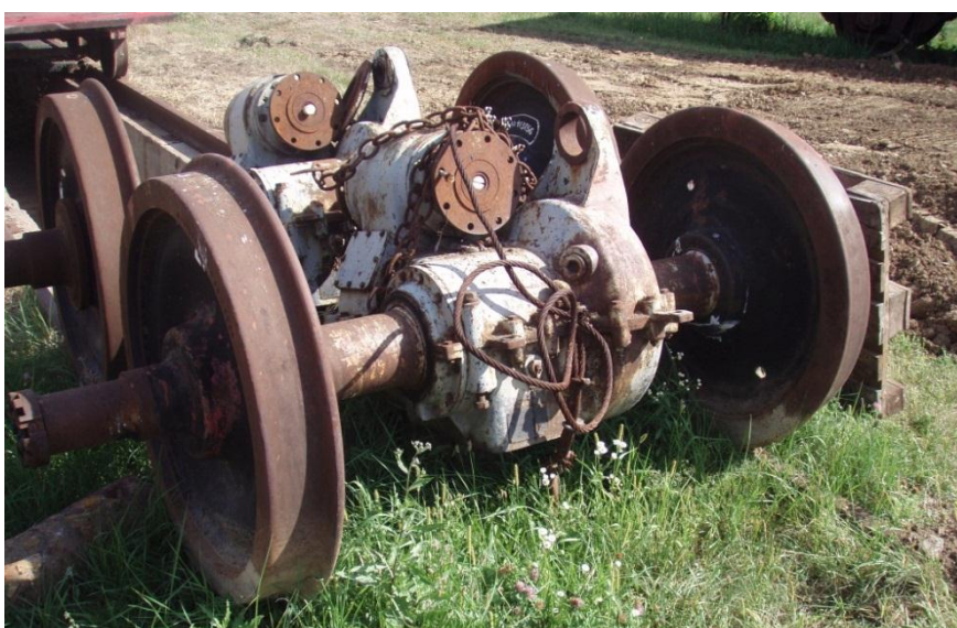
Abbildung 13 Hinterstellte montierte schadhafte Radsätze des VK
