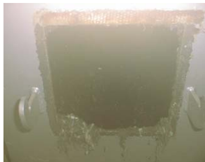
Abbildung 3.7: Probenahmeöffnung für das Mix-Material, 2D und 3D Fraktion gemischt, oberhalb des Auslieferungslagers
