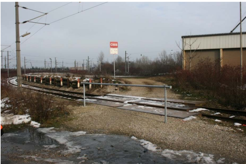
Abbildung 8 Eisenbahnübergang mit straßenseitigem Schranken (Quelle IM)
