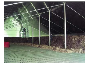
Biofilter Innenansicht
