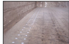
Belüftungsöffnungen Intensivrotteboxen
