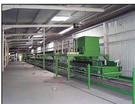
Materialeintrag über Tunneldecke
