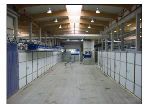
Hallenbereich mit Rottetunnel
