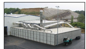
Biofilteranlage
