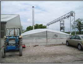
Geschlossener Flächenbiofilter
