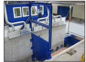
Abluftabsaugung Tiefbunker
