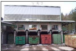
Sortier- und Umladestation
