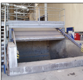
Klärschlamm-bunker
