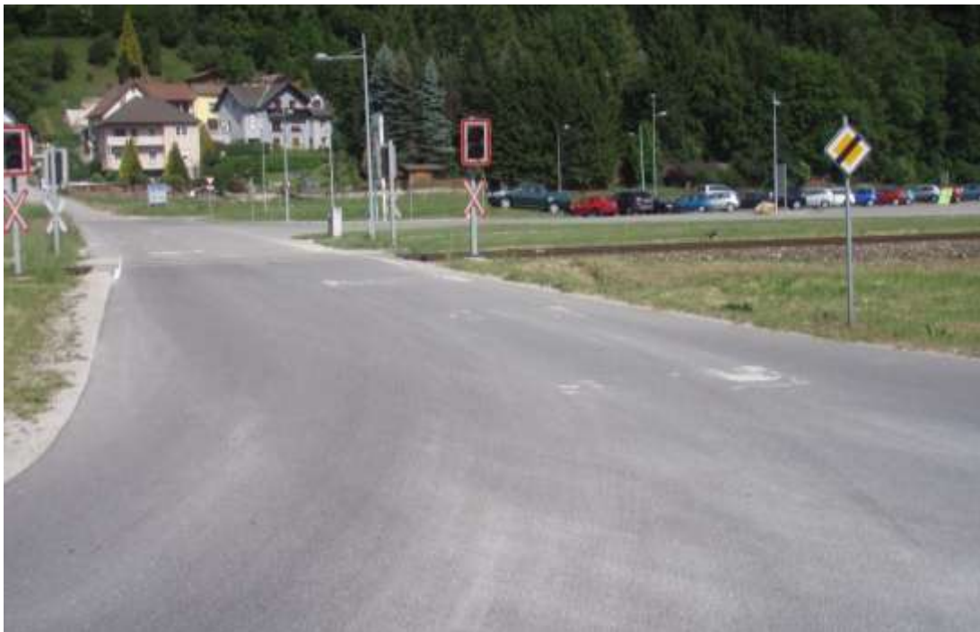
Abbildung 14 Ungenügend sichtbare Bodenmarkierungen der EK km 80,036
