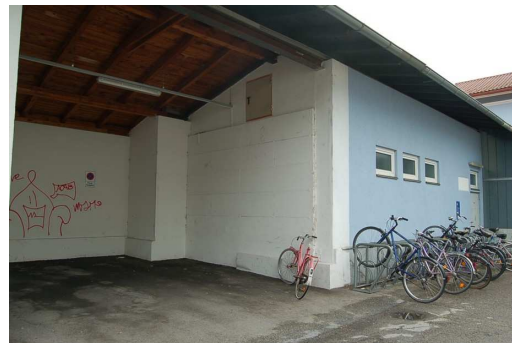
Beispiel für eine mangelhafte Überdachung einer Fahrradabstellanlage, großzügiger Unterstand links davon ist für Kfz reserviert
