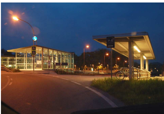
Beispiel für eine Radabstellanlage mit integrierter Beleuchtung und Zuordnung zur Haltestelle
