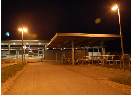
Beispiel für eine Radabstellanlage mit Beleuchtung durch allgemeine Vorplatzbeleuchtung
