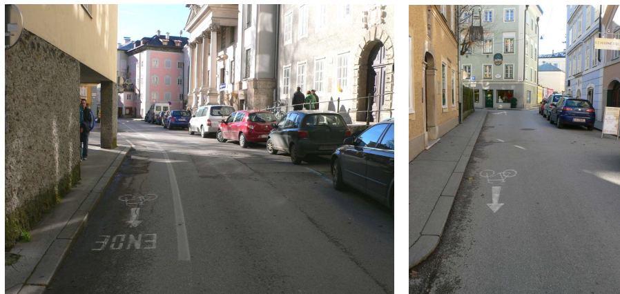
Beispiel für Radfahren gegen die Einbahn (mit und ohne markierten Fahrstreifen für Radfahrer)
