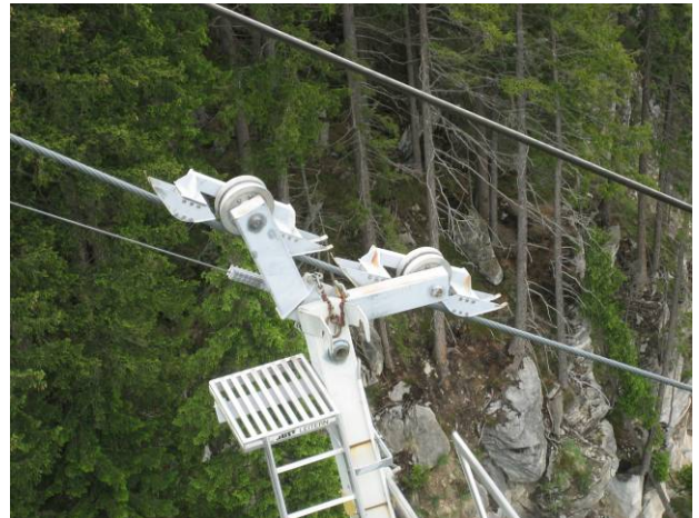
Entgleisungsschutz/ Laufwerk des Bergewagens
