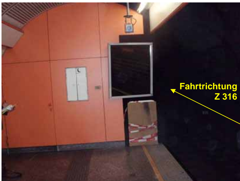
Abbildung 7 Durchgangssperre am Anfang von Bahnsteig 2 in der Station Enkplatz
