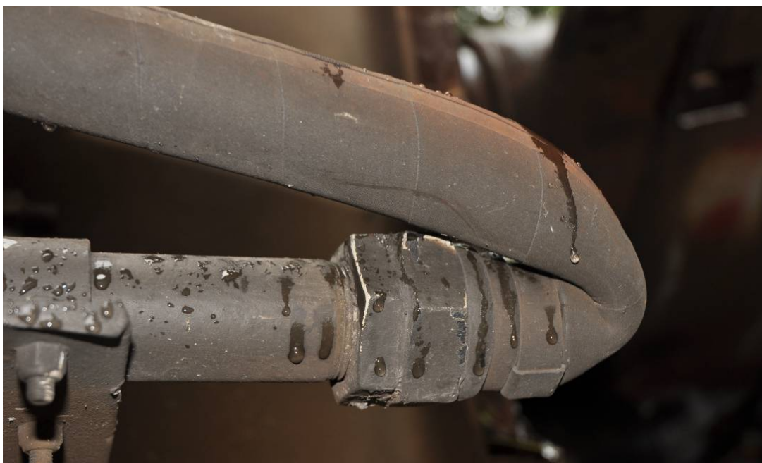
Abbildung 17 geknickter Luftschlauch Detail (Quelle LKA-B)
