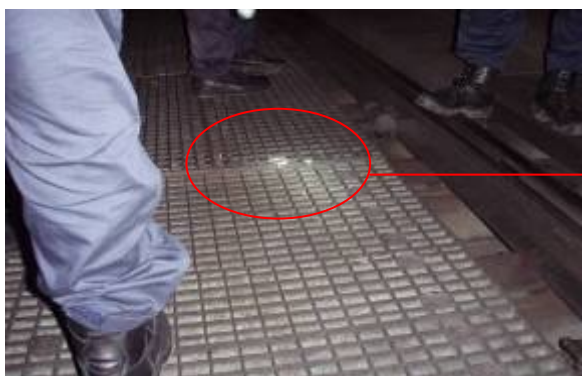
Abbildung 10 Scherspuren im Blisadonatunnel
