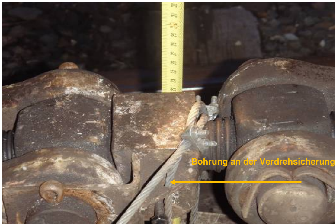
Abbildung 56 Bohrung in der Verdrehsicherung Detail
