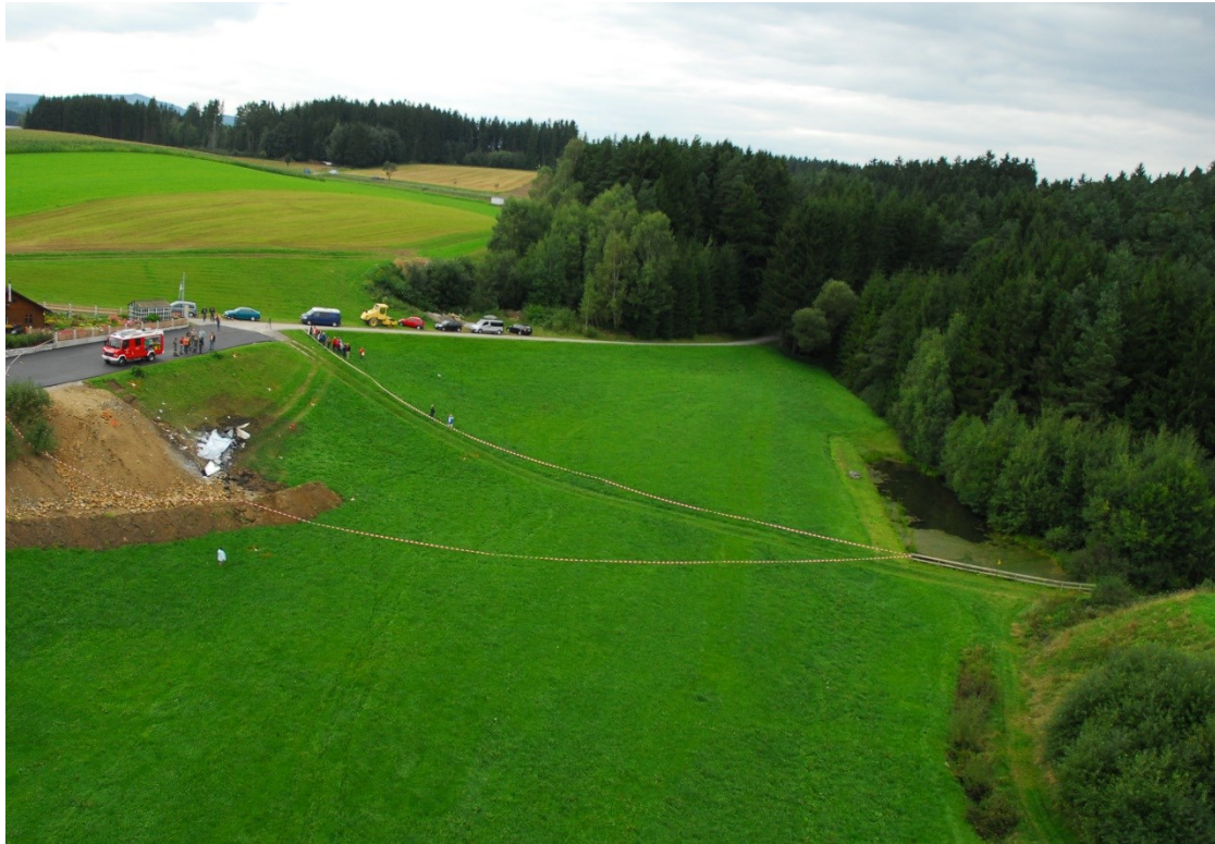
Bild 4: Luftbild der Gesamtansicht der Unfallstelle aufgenommen ca. vom Pistenende 29 des Flugplatzes Freistadt mit Blickrichtung ca. 285°
