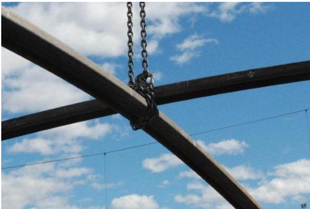
Abbildung 8: Position der Schienen und des Anschlagmittels nach der Kollision (Quelle PI Telfs)
