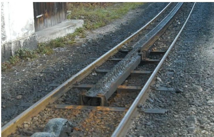
Abbildung 4 Gefedertes Einlaufstück im km 0,205
