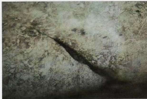
Abb. 4 Von der Mantelfläche ausgehender Riss (Vergrößerung 520-fach)
