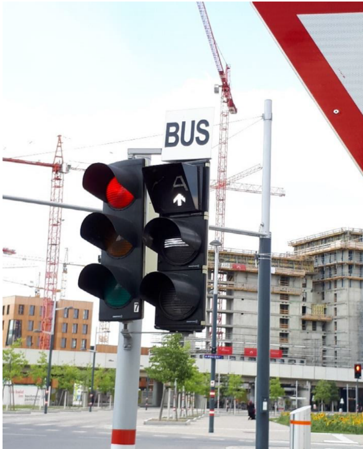
Abbildung 11: Verkehrs-Lichtsignalanlage mit ÖV Bevorrechtigungsfunktion an der Kreuzung Seestadtstraße/Sonnenallee
