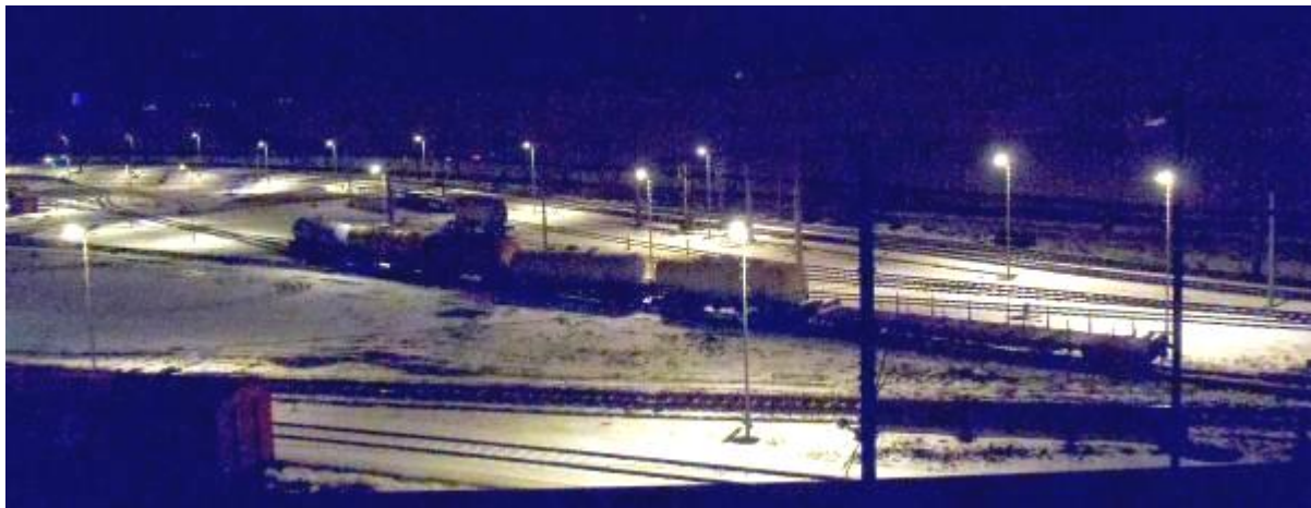
Abbildung 16 Anblick der Entgleisungsstelle vom Betriebsgebäude 1 - Quelle IM
