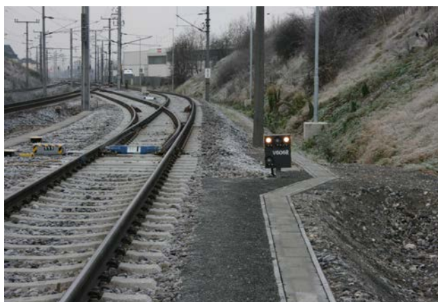
Abbildung 7 Neue Weichenverbindung (Quelle SUB)
