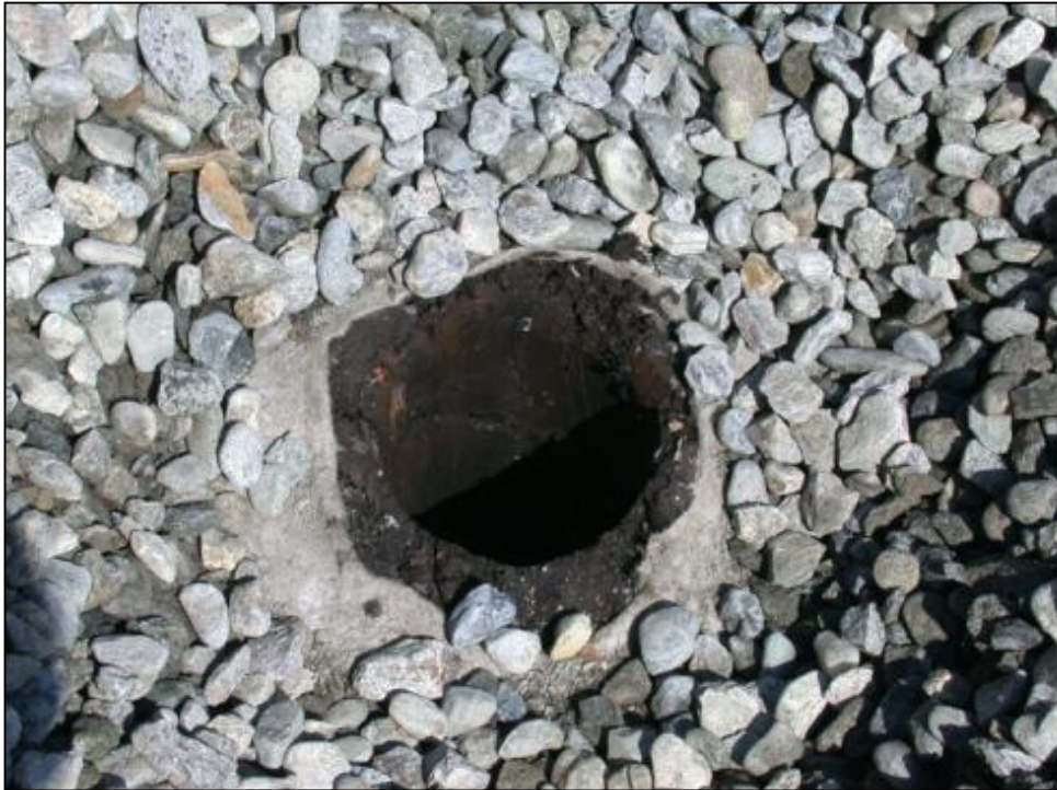
Abbildung 5.15: Verbleibendes Bohrloch der Kernbohrung
