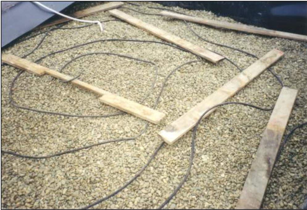
Abbildung 3.5: Schlauchverlegung der Rückbewässerungsleitungen
