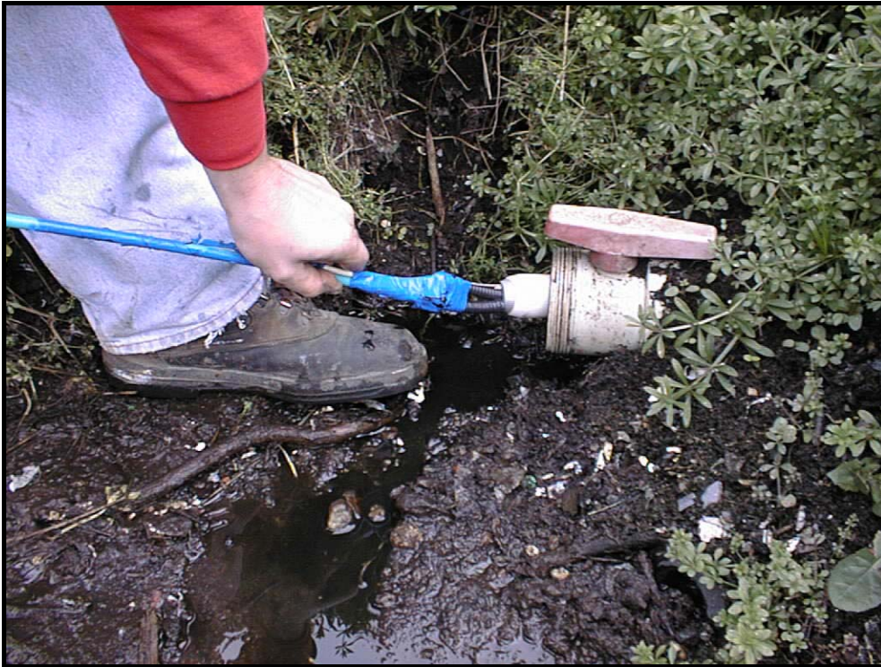
Abbildung 4.20: Einführen der Kanalkamera
