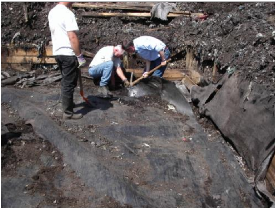
Abbildung 5.10: Entfernung der Abdeckfolie
