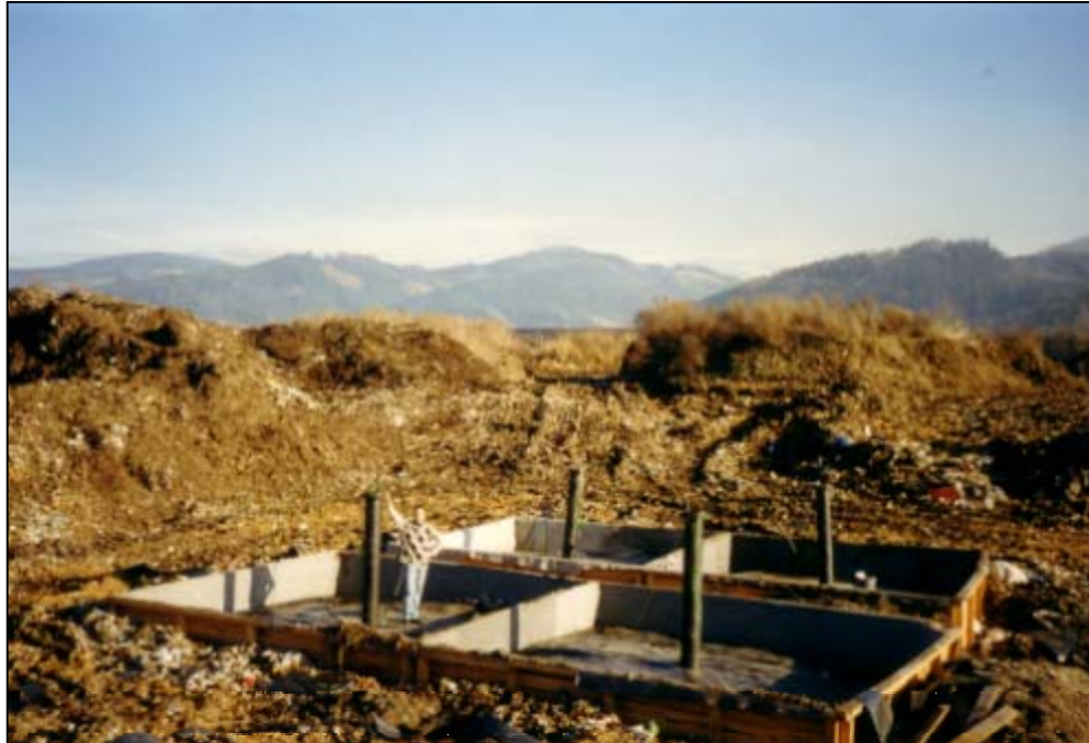
Abbildung 3.8: Fertiggestellte Kompartimente (ohne Überschüttung)
