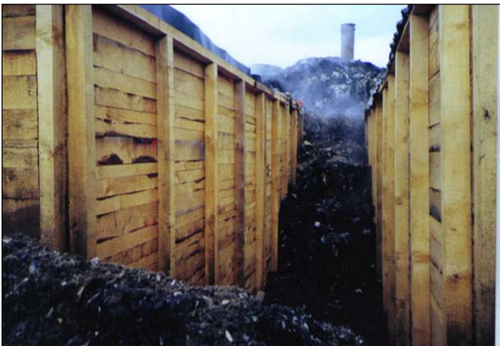
Abbildung 2.6: Verfüllung der Zwischenräume
