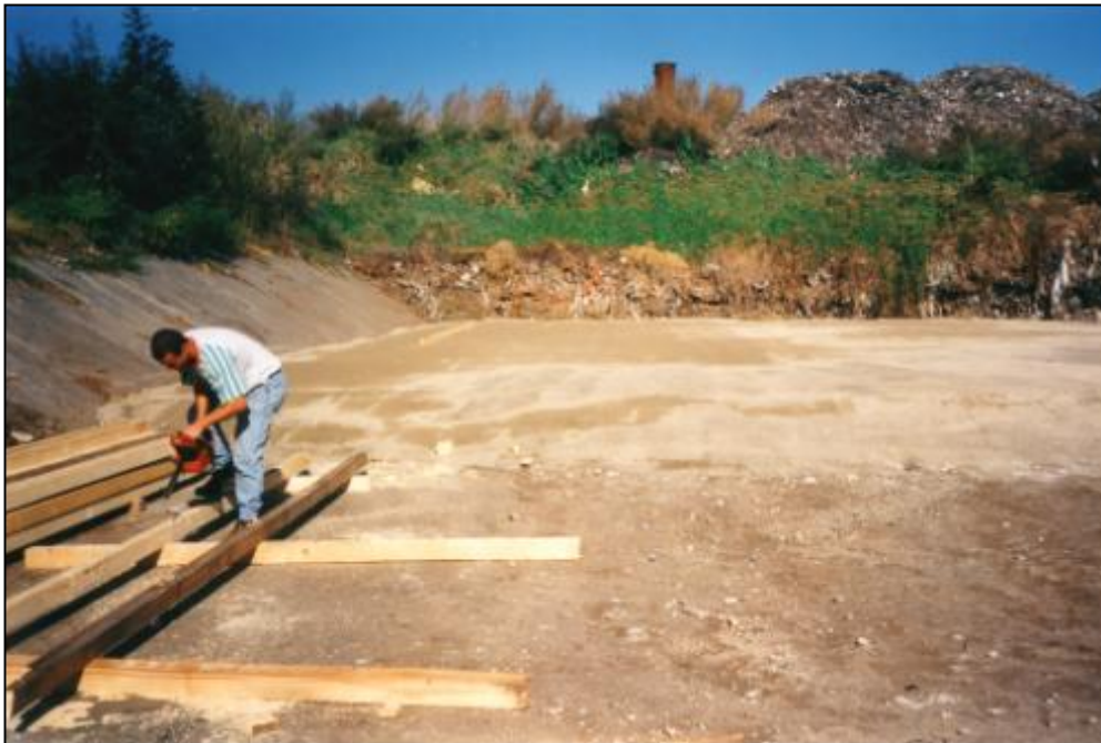
Abbildung 3.1: Beginn der Arbeiten
