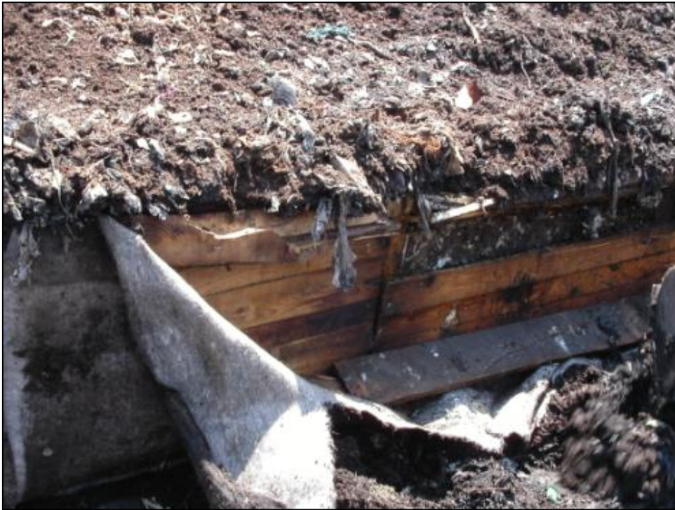
Abbildung 5.9: Stützschalung der Kompartimente
