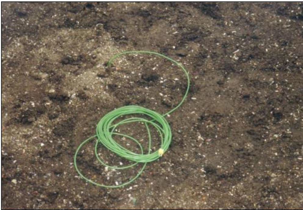
Abbildung 3.3: Thermofühlerkabel im eingebauten Material
