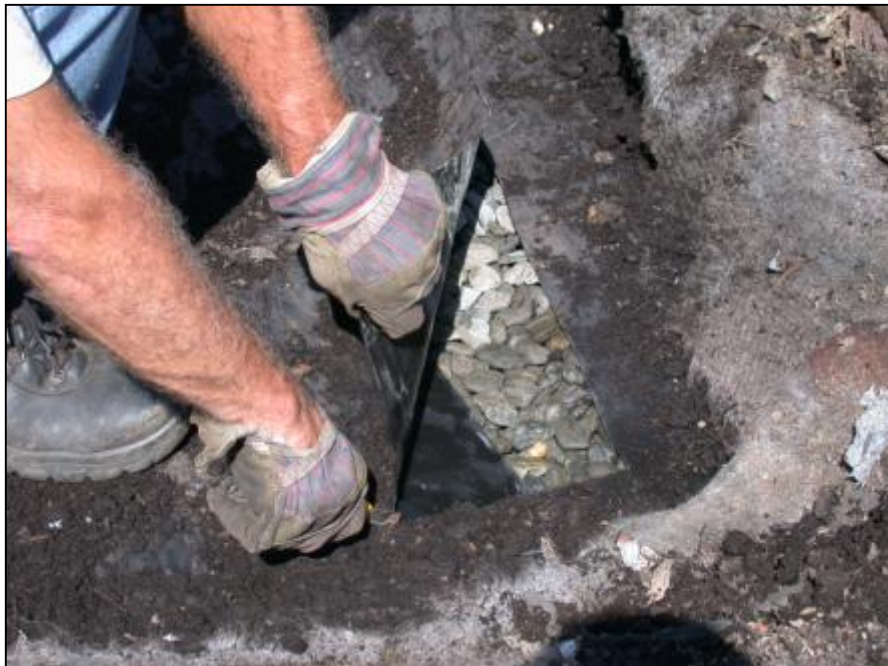
Abbildung 5.12: Entfernen der Abdeckfolie
