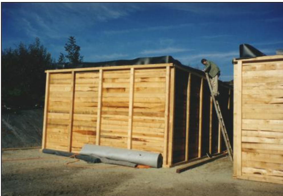
Abbildung 3.2: Errichtung der Stützschalungen
