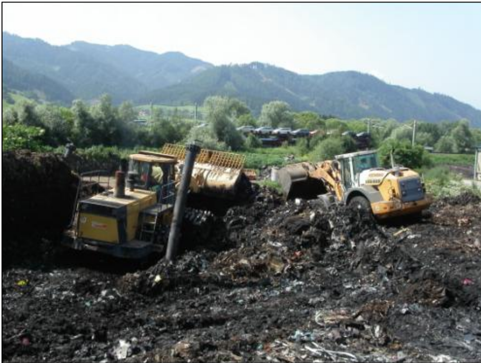
Abbildung 5.5: Entfernen der Überschüttung
