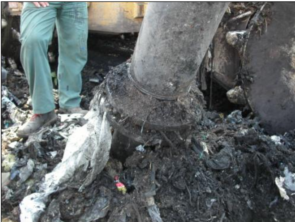
Abbildung 5.7: Verbindungs- muffe am Entgasungsrohr
