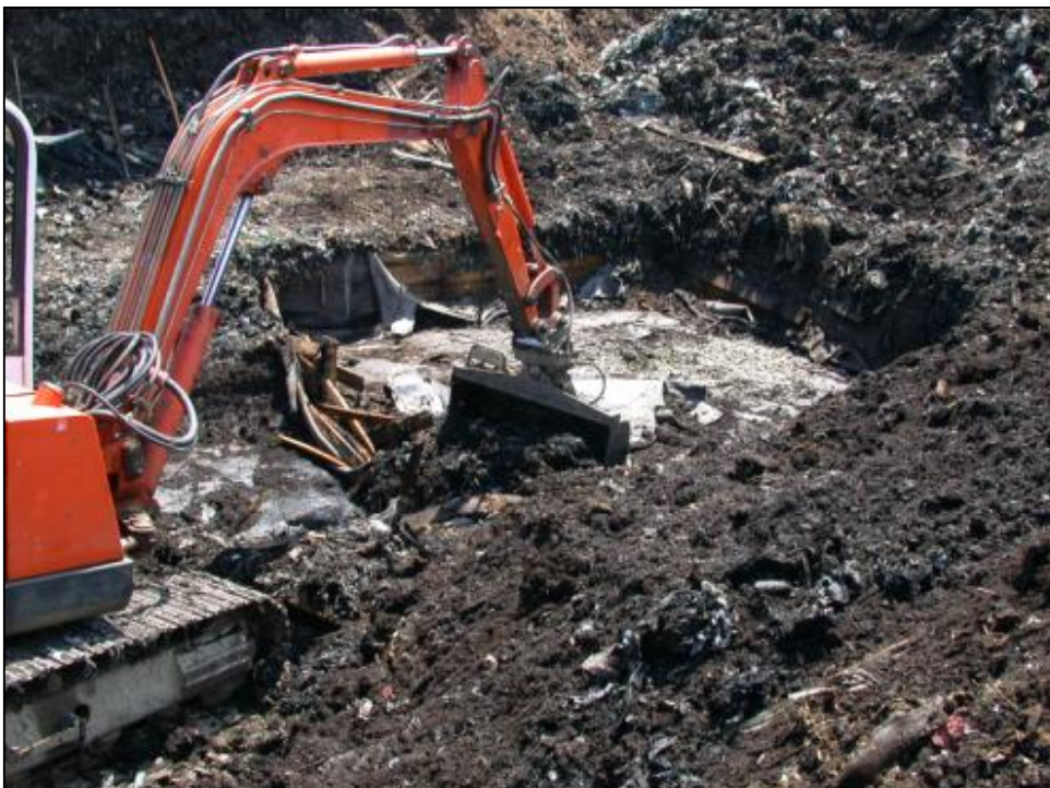
Abbildung 5.8: Minibagger für Feinarbeiten
