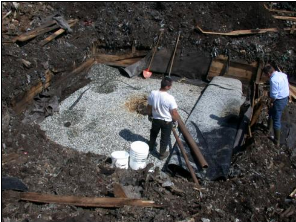
Abbildung 5.13: Vorbereitung für Bohrkernentnahme
