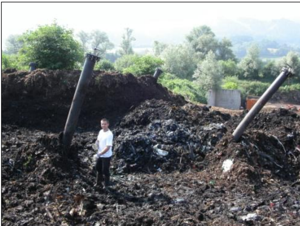
Abbildung 5.6: Entfernung der Überschüttung
