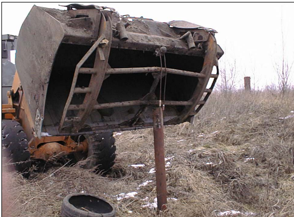
Abbildung 5.3: Ziehen des Rohres mittels Radlader
