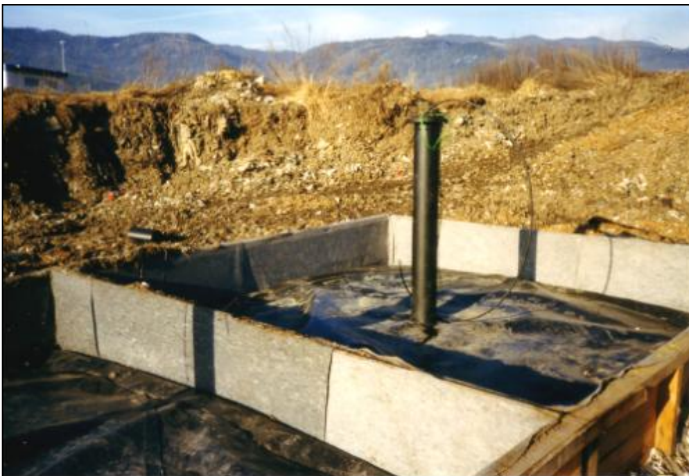
Abbildung 3.6: Verschweißtes Kompartiment
